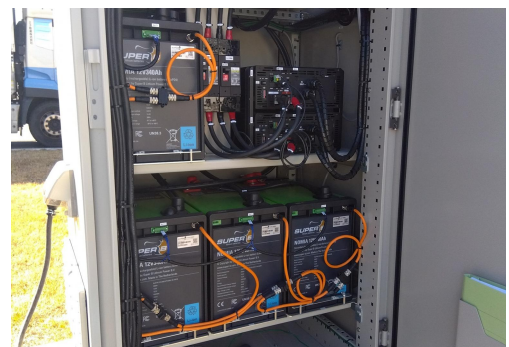
【写真：路面太陽光発電設備(左) 蓄電池(中央、右)】
