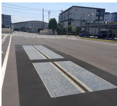
【写真：路面太陽光発電設備(左) 蓄電池(中央、右)】
