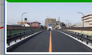
橋りょう 長寿命化修繕事業
