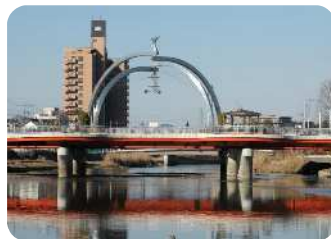
古利根公園橋
