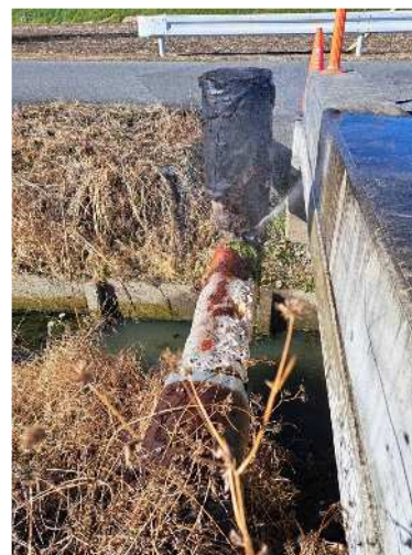
老朽化による漏水
