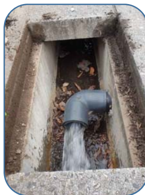
末端監視装置（小溜）と洗管排水作業
