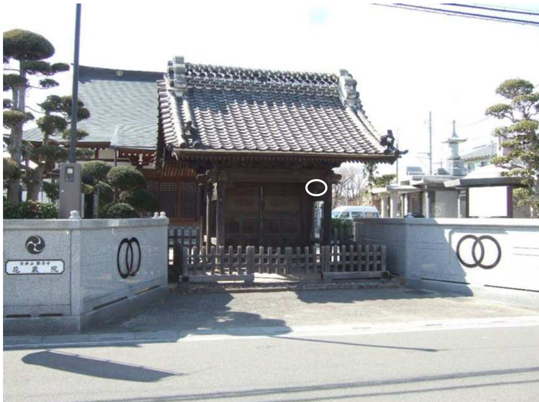
毀損前 外観（丸印が今回の毀損箇所）
