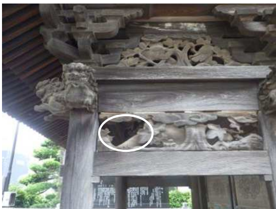
毀損状況 彫刻の透かしの一部が外れ落下
