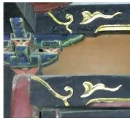
写真5：厨子上部の虹梁
