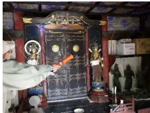
▲薬師堂内の厨子の状況
