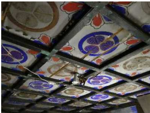
▲薬師堂内の格天井
